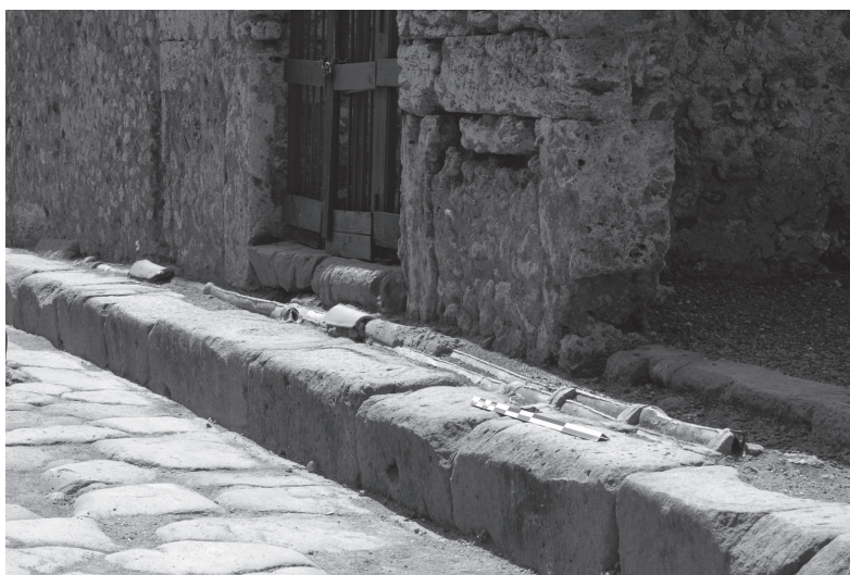
Figure 3. Conduites de plomb courant sur le trottoir de la rue des Vettii (VI 13) (photo H. Dessales).
